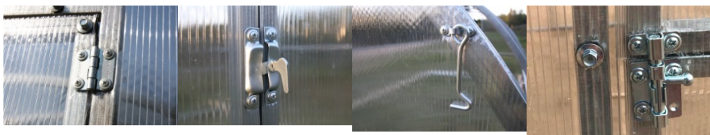
Pav. 16 Suktukų, skląsčių, lankstų, kabliukų tvirtinimo vietos ant šiltnamio arkos
